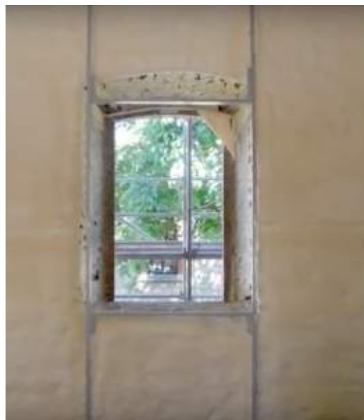
Aislamiento interior con espuma de poliuretano
