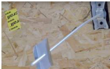
Neopreno en perforación para varillas
