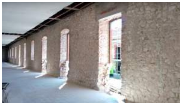
Interior del cerramiento original
