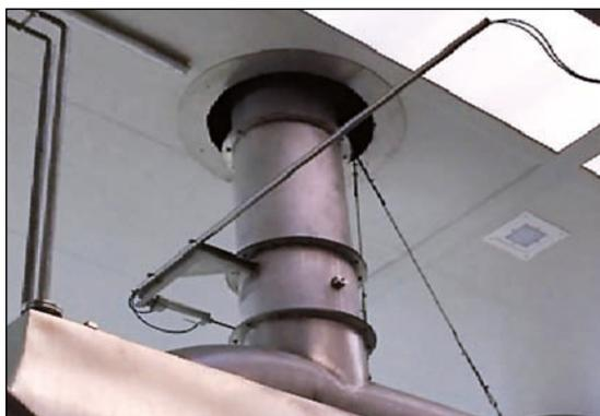
Figura F8.3. Paso de conductos a través de paneles, con collarín
