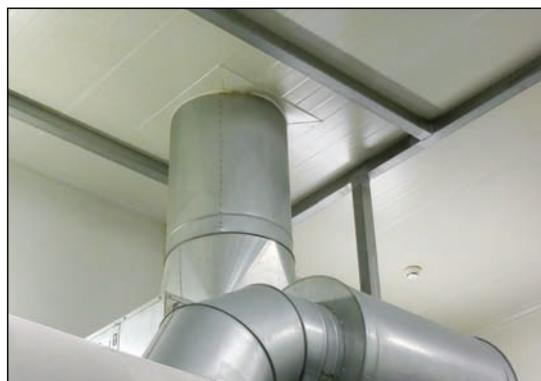
Figura F8.4. Paso de conductos a través de paneles
