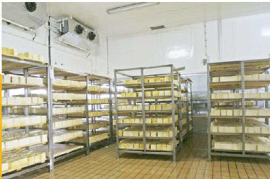
Los almacenes frigoríficos se construyen casi siempre utilizando paneles sándwich con núcleo de poliuretano y revestimiento de acero.
